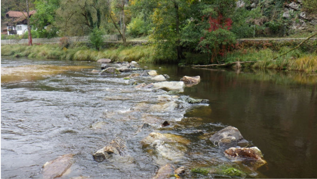
Abb. 6: Fertiges Störsteinfeld in dichter Formation
