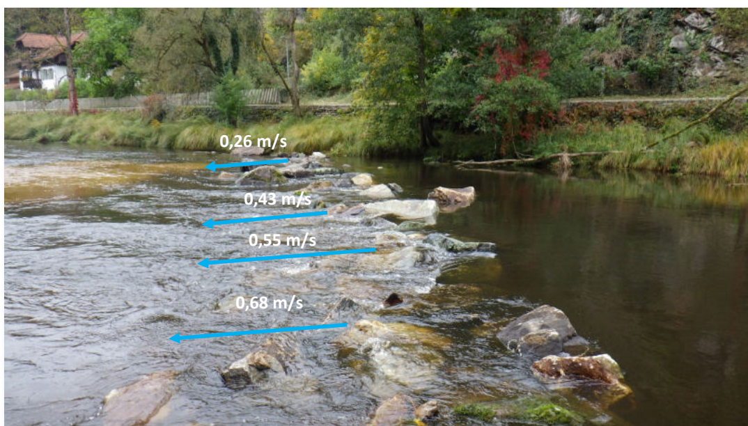
Abb. 8: Anstieg der Fließgeschwindigkeiten in den Durchlässen des Störsteinfeldes von der rechten zur linken Uferseite
