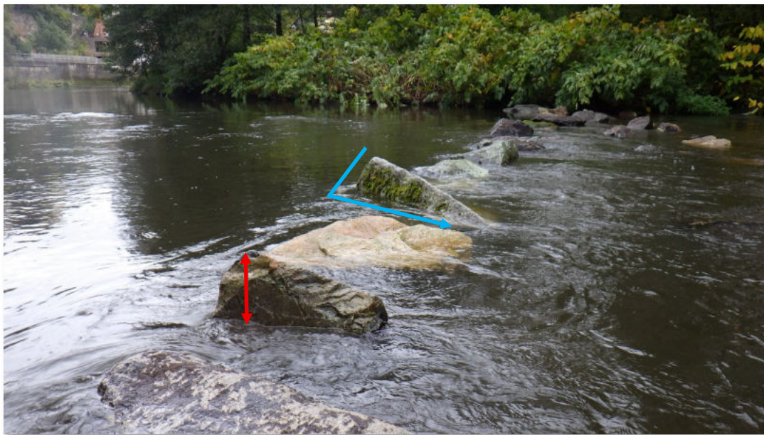
Abb. 5: Grundreihe Störsteinfeld mit zunehmender Steingröße zur Flussmitte. Blauer Pfeil: Einflusswinkel 90^\circ zwischen zwei Störsteinen; Roter Pfeil: Steinspitzen oberhalb des Wasserspiegels
