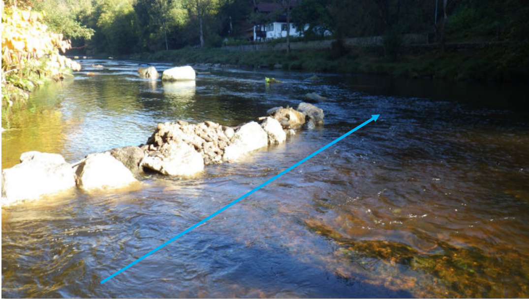
Abb. 2: Leitbühne unterhalb Einstieg FAA Hals
