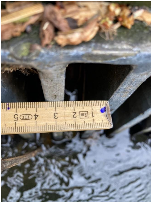
Foto 4: Detailansicht 1 Stababstand/Lichte Weite Feinrechen (25 mm) Wehranlage
