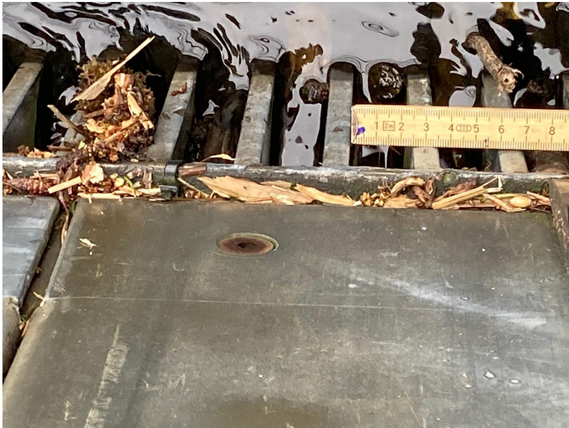
Foto 5: Detailansicht 2 Stababstand/Lichte Weite Feinrechen (25 mm) Wehranlage
