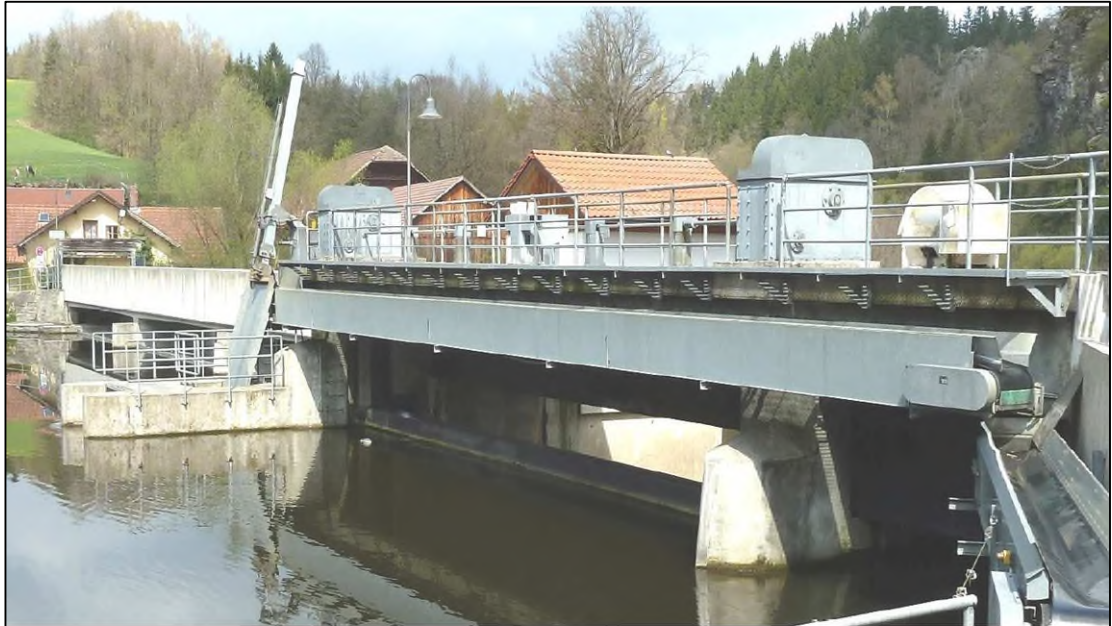
Abbildung 3: Wehranlage Hals an der Ilz, von oberstrom (Quelle: G1)
