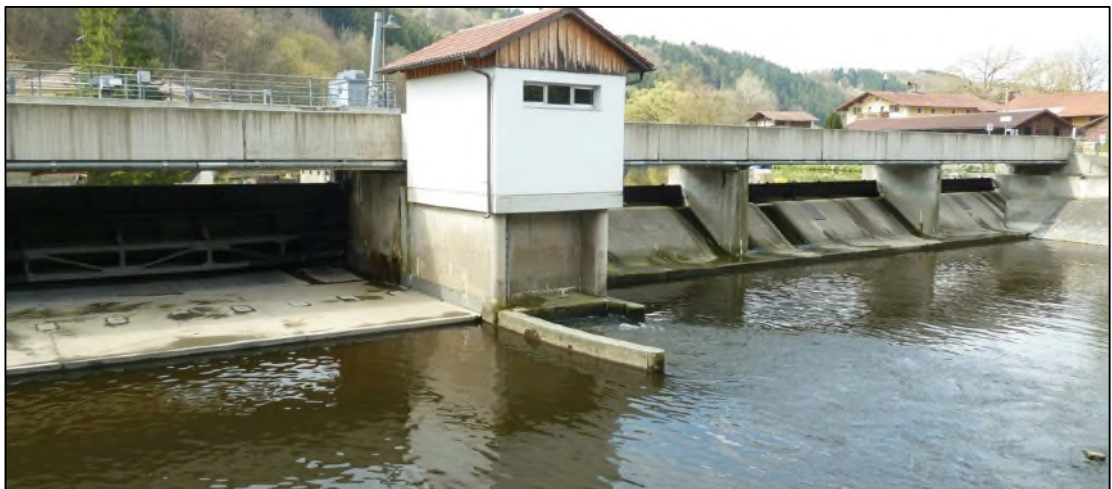
Abbildung 4: Wehranlage Hals an der Ilz, von unterstrom (Quelle: G1)
