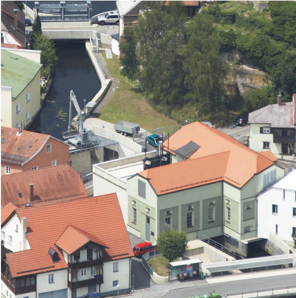
Abb. 5: Luftbild vom Wasserkraftwerk
