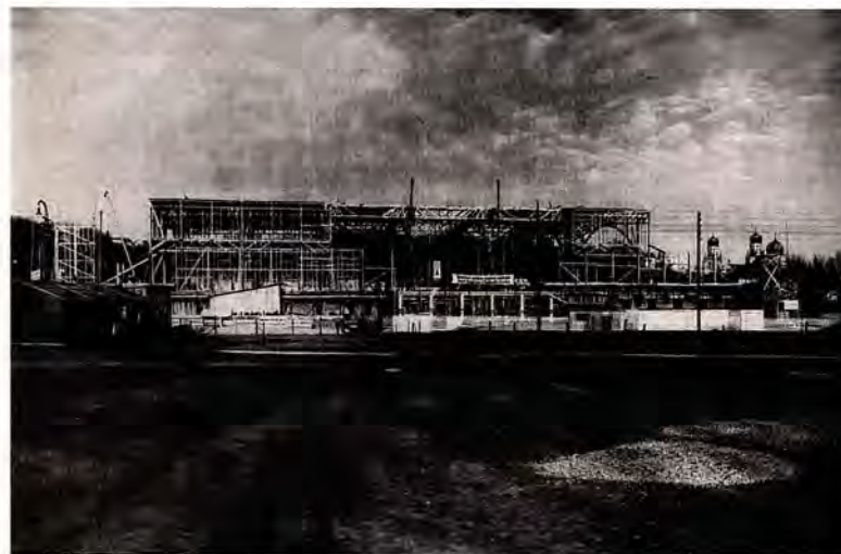
Bau der Nibelungenhalle im Jahre 1934
