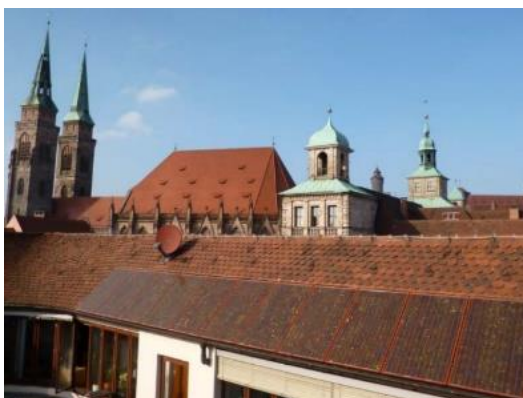
Abbildung 51: Terrakotta-Solardach in Nürnberg
