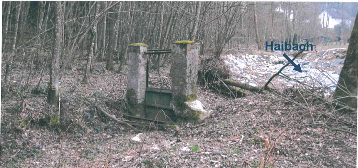
Abbildung 6: Ausleitung gegenüber Bayerisch Haibach Hs. Nr. 28 (Blick von unten)
