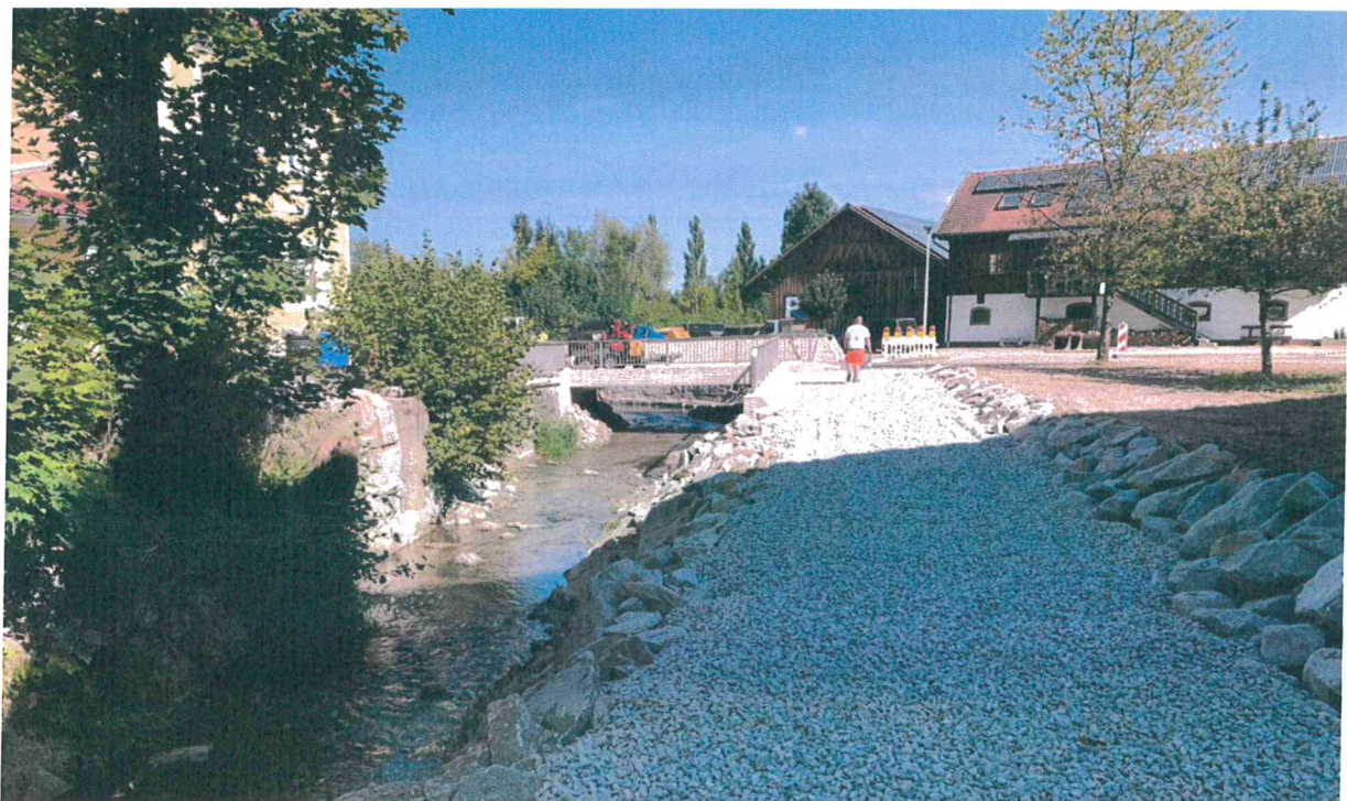
Abbildung 4: Ersatzneubau Haibachbrücke 2019 mit Uferabtrag und Stützwand am rechten Ufer
